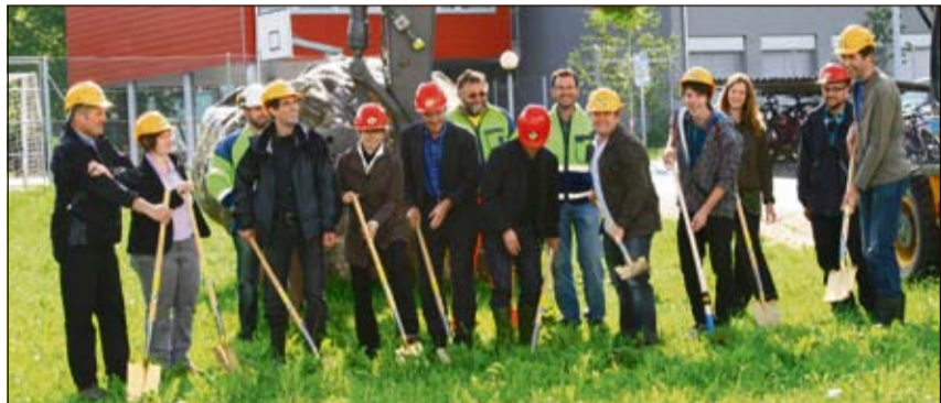
Die Verantwortlichen beim Spatenstich.
